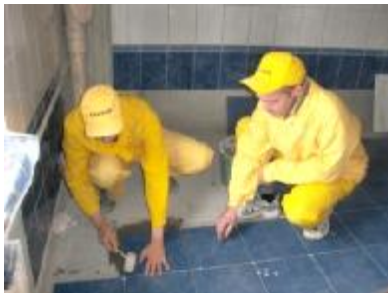
Укладання плитки на підлогу
