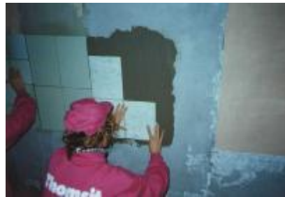
Укладання плитки на стіни
