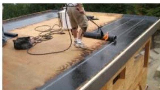
Курс "Виконання робіт з улаштування покрівлі із рулонного матеріалу"
