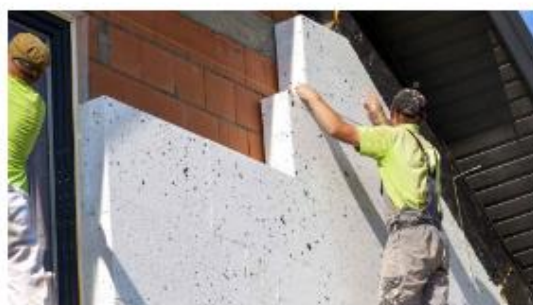
Курс "Виконання робіт з монтажу системи утеплення будівель"
